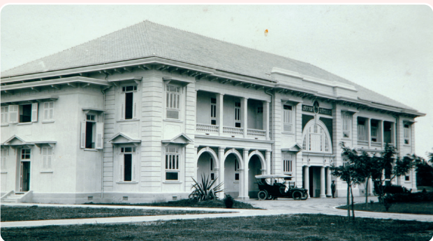
สถานเสาวภา อนุสรณ์สถานคูโรงพยาบาลจุฬาลงกรณ์
